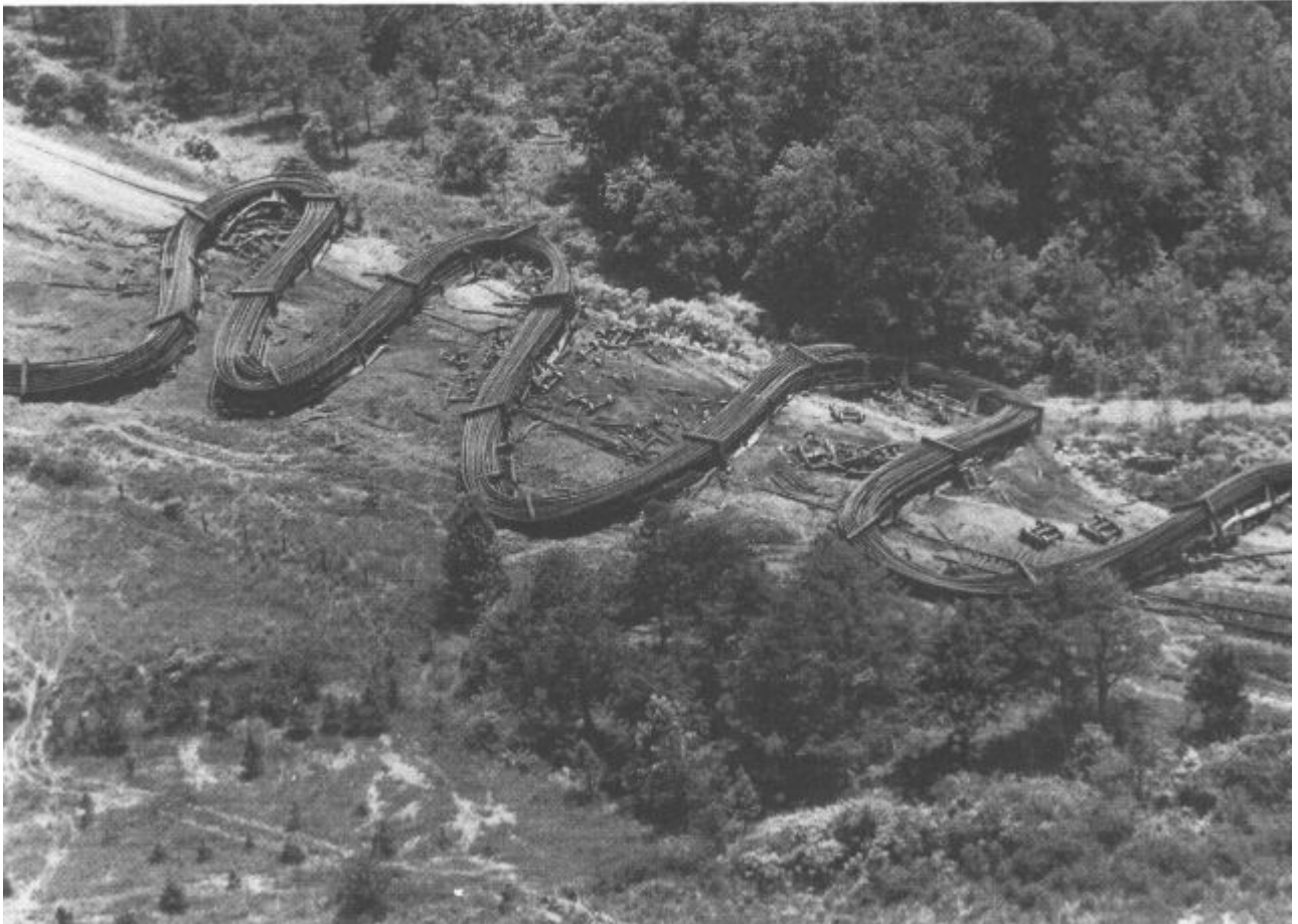
I-13. ábra. 250 m hosszú sínszalakat szállító vasúti szerelvény kisiklásának következményei, Goldsboro, USA. AP-felvétel, közli Leopold (1994). A deformáció egyenletes eloszlása miatt a sínszalak a meanderívekkel azonos alakra torzultak.
